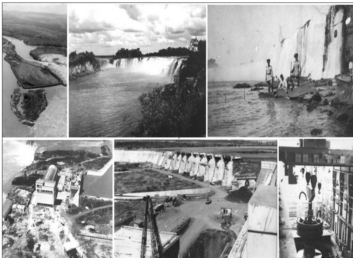
Figura 3 – Panorama de modificação da paisagem: da chegada das autoridades para avaliar o potencial da região, passando pelas intervenções infraestruturais até ao cumprimento da primeira etapa, com a instalação da primeira turbina geradora — as fotografias cobrem um período que vai dos anos iniciais da década de 50 até 1960. As obras começaram em 1954. Em 1960, Juscelino Kubitschek inaugurou a primeira etapa, quando a primeira turbina começou a gerar a energia que iluminaria a capital federal. Fonte: ROCHA, 2005.
